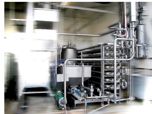
PLANTA DE PROCESO DE RESODUOS CÁRNICOS
